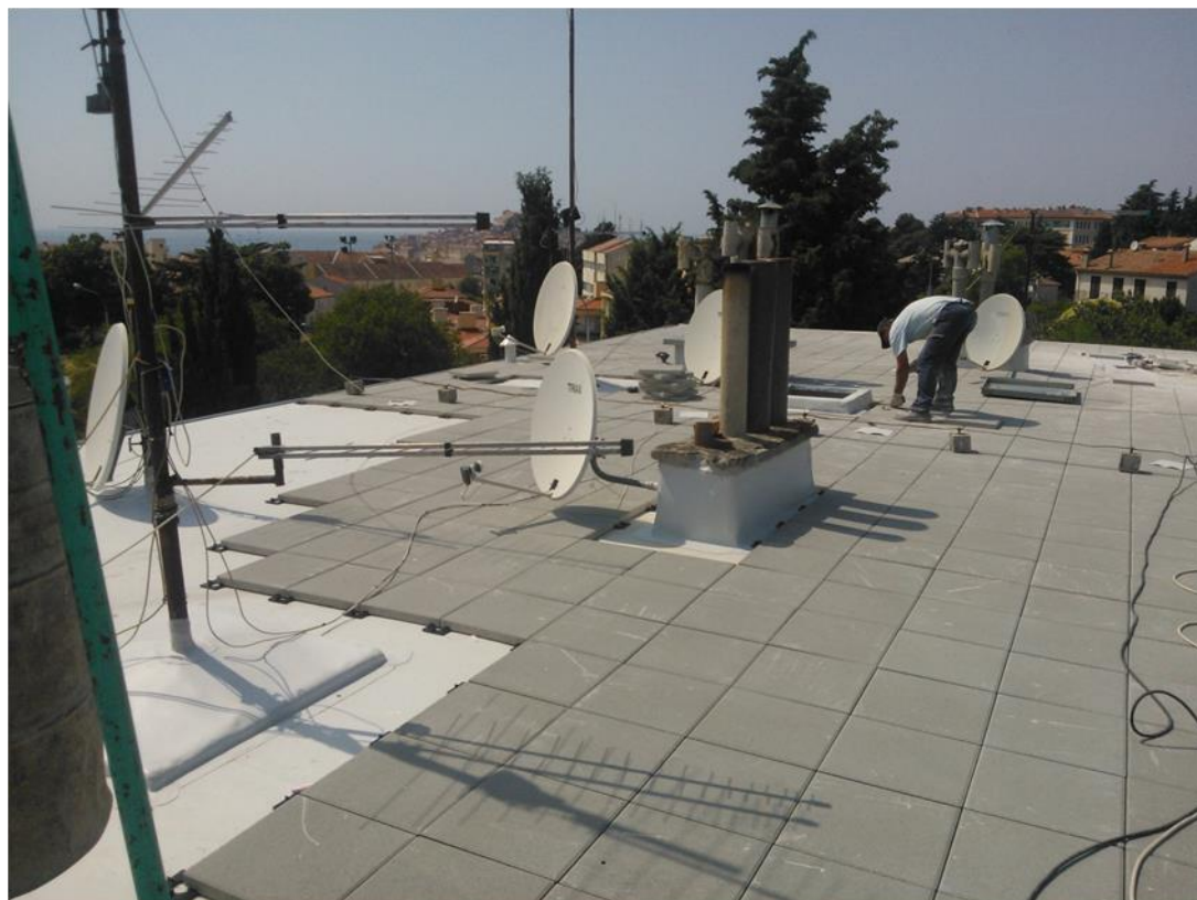
ravni krov zgrade u Rovinju, Omladinska br.27
