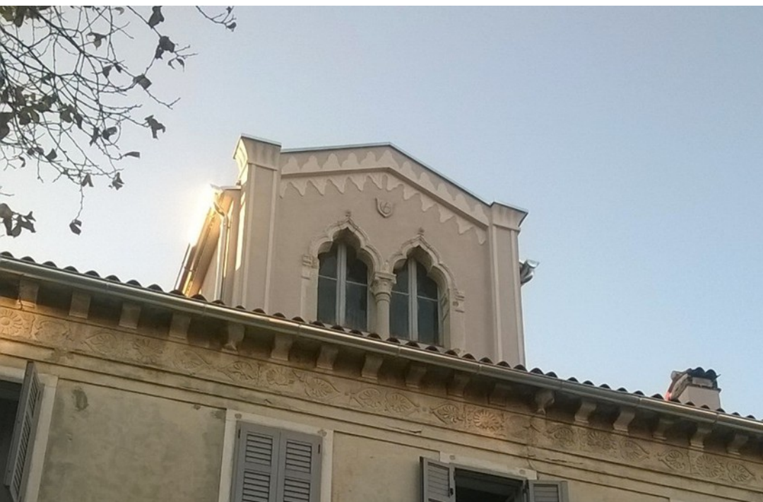
Krov zgrade Carducci 7
